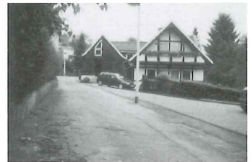
Die unter Denkmalschutz stehende Scherenschleiferei wurde zum Teil eines Wohnhauses, 1997
