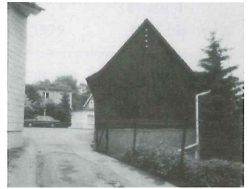
Werkstattgebäude einer heimgewerblichen Scherenschleiferei, 1987
