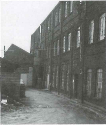
Rückansicht der ehemaligen Dampfschleiferei Loos in Solingen-Widdert, 1986. Die einzelnen Räume des Gebäudes waren noch an Schleifer vermietet
