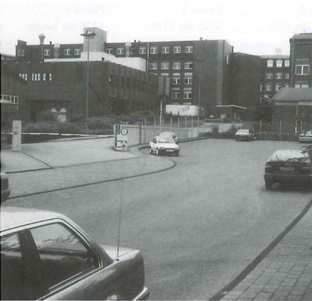
Große Teile des Fabrikensembles des Henckels-Zwillingswerkes sind einer Standort-Modernisierung zum Opfer gefallen, 1997
